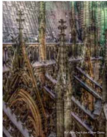
Auf dem Dach des Kölner Doms
